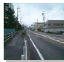
車道(歩道あり)
